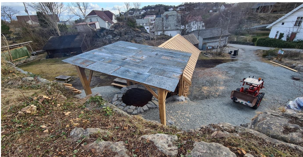
Figur 1: Kalkovnen ovenfra, med ovnstopp, bakfylling, tak og grindbygg. Se også tittelbilde. Foto: Bent Morten Steinsland
